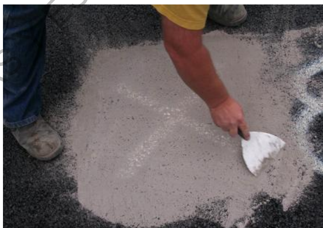
Figura 746 - 1. Nivelación de la superficie con arena
